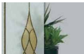
Kirchenfenster mit verfärbten Elementen und Bleieinlagen
